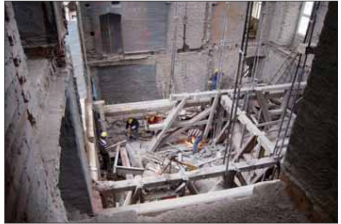
Abbruch der Hängekonstruktion im Südtrakt
