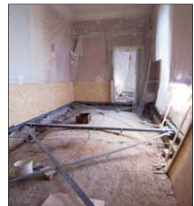
Stahlverhängung eines Gewölbes
