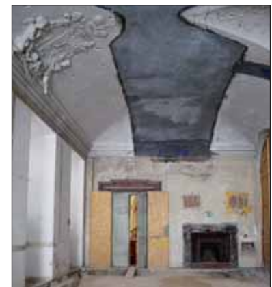
Verpressung eines Gewölbes
