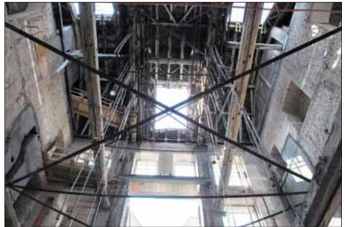
Südtrakt nach Abbruch der Hängekonstruktion
