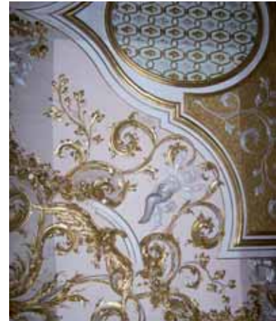
Speisezimmer, Musterfläche Deckenstuck
