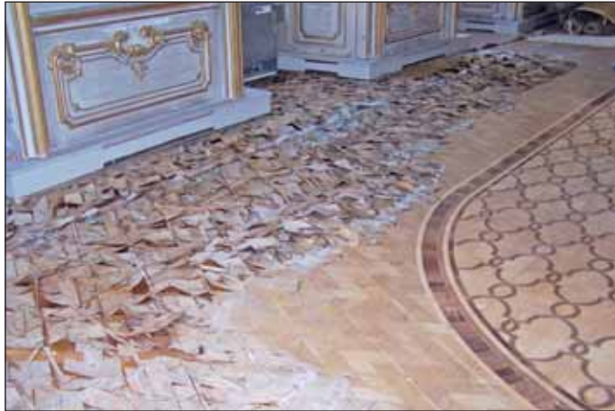
Der Thonetboden im Bouquetsaal im 2. Stock vor Restaurierung
