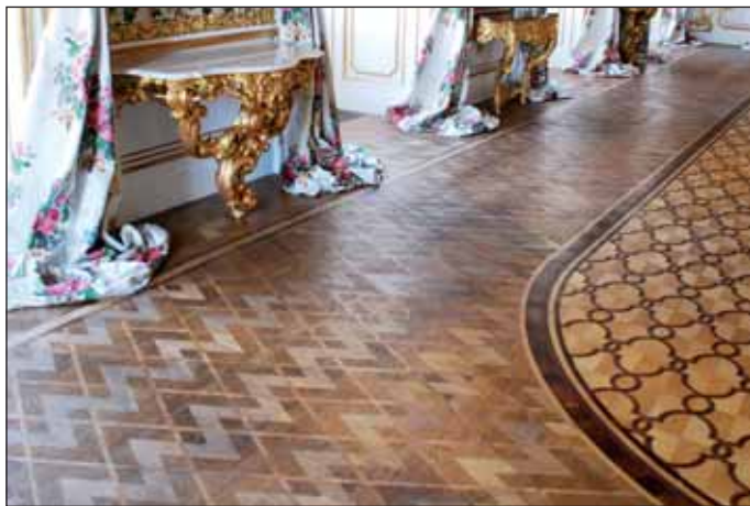
Der Thonetboden im Bouquetsaal im 2. Stock nach Restaurierung
