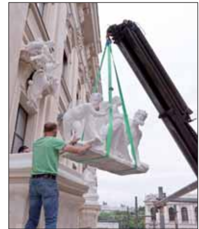
Versatz Bauplastik über dem Hauptportal
