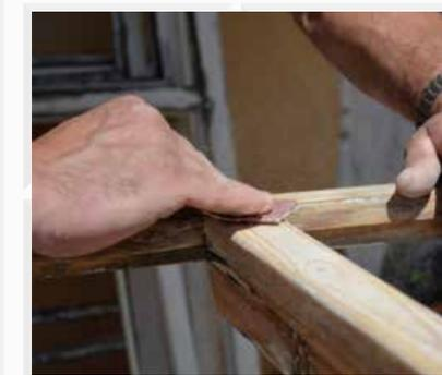
Die achteiligen Sprossenfenster, von denen die unteren vierteiligen Flügel separat zu öffnen sind, besitzen eine Wetterschiene. Die Verwitterungsschäden treten nach Abnahme der Beschläge voll zu Tage.
