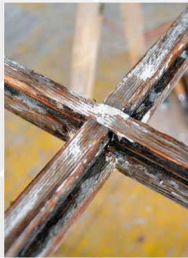
Nach Entfernen der alten Lackschichten und Beschläge wurden die Verwitterungsschäden deutlich sichtbar. Sämtliche Holzverbindungen an den Rahmen der Sprossenfenster wurden holztechnisch gerichtet und instandgesetzt – unter besonderer Berücksichtigung, die originalen Holzteile weiter zu verwenden. Überall, auch bei den teilweise erneuerten Flügeln wurden die Originalglasscheiben wieder verwendet und mit Fensterkitt in die vorhandenen Nuten der Sprossenfenster eingesetzt.
