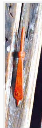
Die außenliegenden, vom Rahmen des achteiligen Sprossenfensters abgehobenen Stützkloben wurden mit Rostschutzfarbe gestrichen. An diesen werden die vierteiligen, separat zu öffnenden Sprossenfenster angeschlagen.
