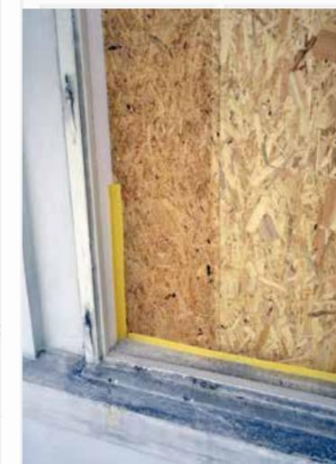
Die Fensterstöcke wurden mit Holzfaserverplatten und Folien staubdicht abgedeckt. So konnte in den dahinterliegenden Räumlichkeiten der Betrieb weitgehend störungsfrei aufrecht erhalten werden.
