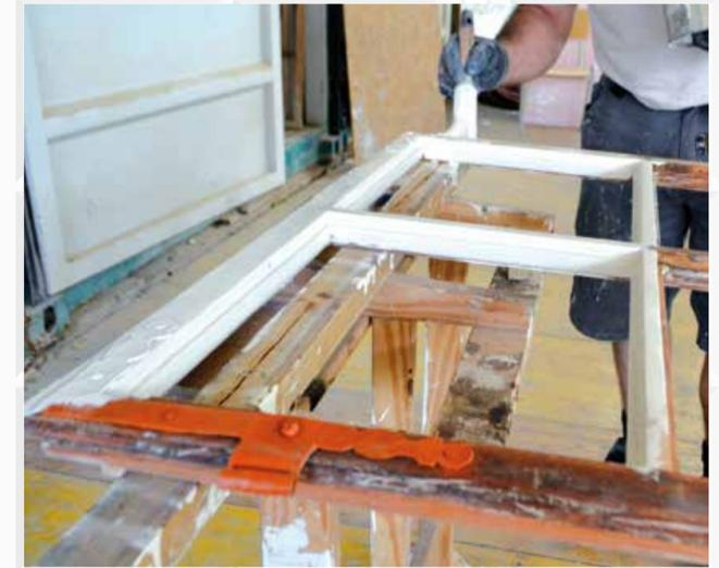
Alle Holzoberflächen, Zargen, Rahmen und Sprossenfenster wurden von alten Anstrichen gereinigt und mit heißem Leinölfirnis grundiert. Anschließend wurden die mit Rostschutzfarbe behandelten Beschläge montiert und das gesamte Fenster mit weißer Ölfarbe entsprechend dem Originalbestand neu gestrichen.
