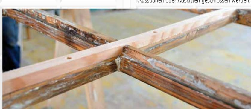
Abgewitterte Holzteile wurden mit Handsägen auf Reparaturtiefe eingeschnitten und anschließend an den betroffenen Partien mit dem Stecheisen abgearbeitet. Die Verlustzonen wurden durch Aufdoppeln mit neuem Material egalisiert. Breite und tiefe Risse konnten durch Ausspänen oder Auskitzen geschlossen werden.
