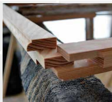
Die Sprossenfenster zeigten massive Holz- und Stabilisierungsschäden an den Ecken. Die aufgesetzten Profile an den Stäben sowie alle nicht mehr verwendbaren Rahmen und Sprossen wurden mit Lärchenholz ergänzt.
